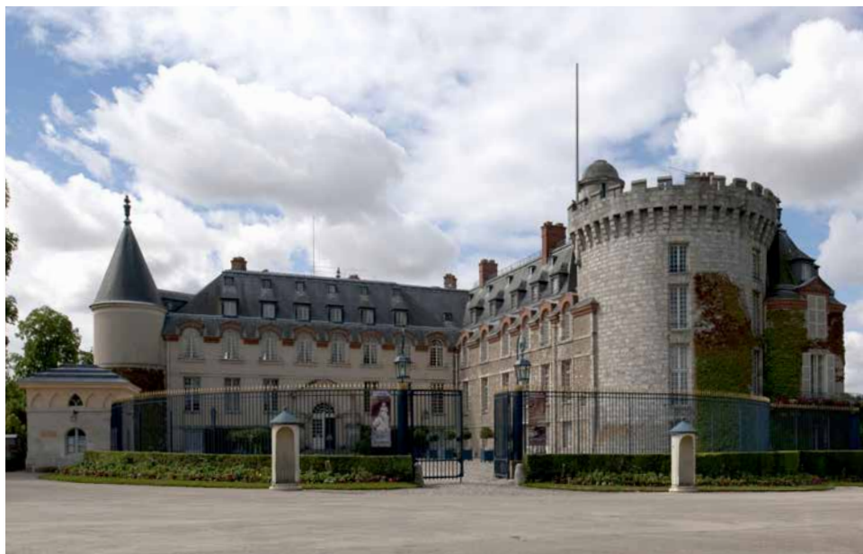
> Façades sur cour
